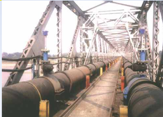
700 mm 2 nos. flow meters for DI & CI pipeline.
